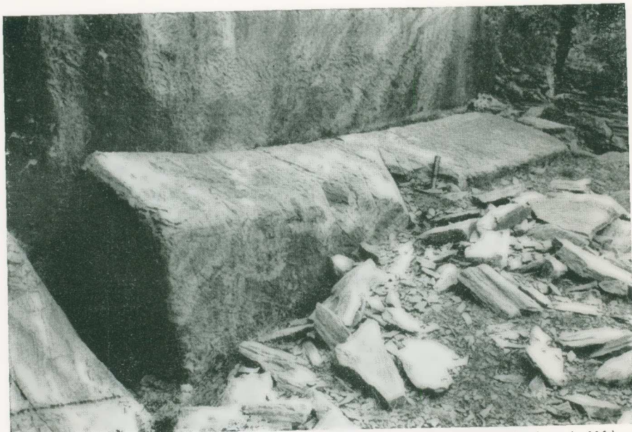
Εικ. 15.—'Ορθογώνιος ὀγκόλιθος ἀπομονωθείς διὰ περιφερικῶν ἀλάκων (φαλκῶν), ἀλλὰ μὴ ἀποκολληθεὶς κατὰ τὴν βάσιν του. Ἀρχαῖα λατομεῖα τῆς θέσεως Καρατζᾶ.
