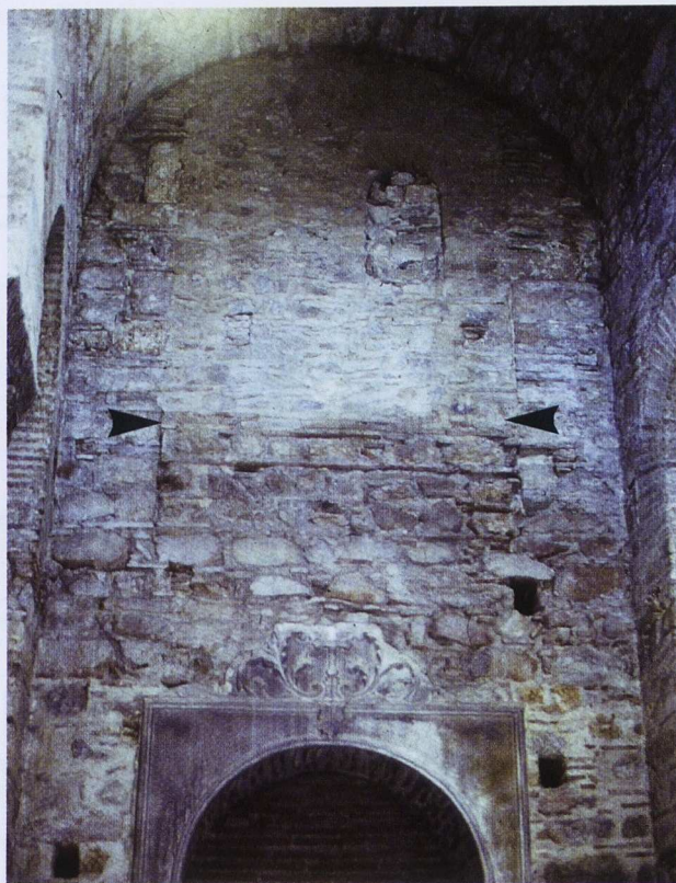
Εικ. 39. Ναός της Παναγίας (α) ἐγκάρσια τομή Β-Β, βλέπουσα δυτικά (β) ἐσωτερική ἄποψη τοῦ τοίχου τῆς δυτικῆς κεραίας. Διακρίνονται καθαρά τὰ ἴχνη τοῦ ἀνοίγματος «i-a-i».
