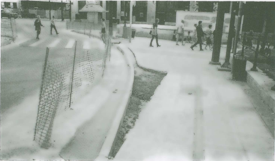
Είκ. 18. Έθνική Βιβλιοθήκη. Νέα ασύμμετρη διάταξη τής πλατείας πρό τής Βιβλιοθήκης, με παραμόρφωση τής όδοϋ Ρήγα Φεραίου, για να δημιουργηθεῖ ὁ κατάλληλος χώρος για τήν εἴσοδο-ἐξοδο τοῦ METPO (Φωτ. Π.Μ.Μ. 1998).
