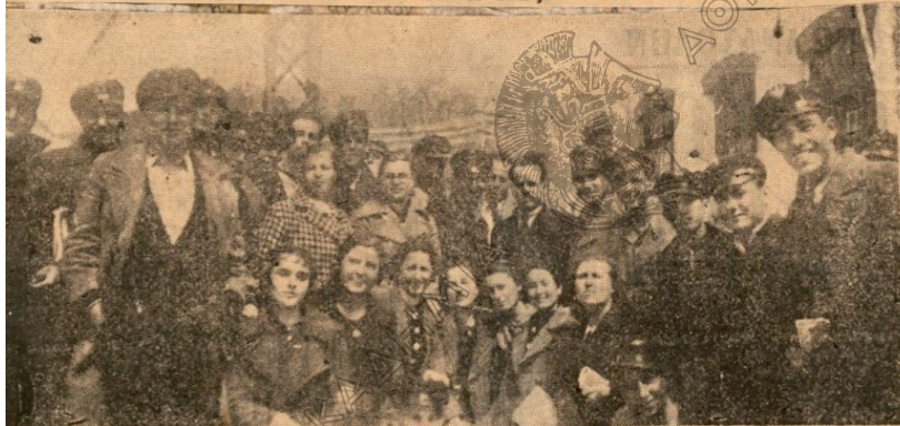
Οἱ τελειόφοιτοί τοῦ Γυμνασίου Ξάνθης μετὰ τοῦ καθηγητοῦ τῶν τῶν Φυσικῶν, κατὰ μίαν ἐπίσκεψίν των εἰς τὸ ἐργοστάσιον τοῦ ἠλεκτροφωτισμοῦ τῆς πόλεως ταύτης, ὅπου τοὺς ἐγένετο σχετικὸν μάθημα.
