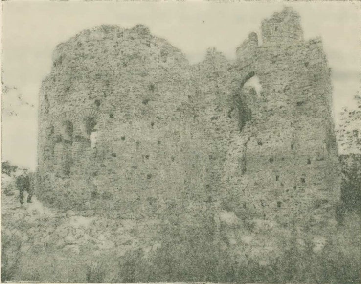
Εἰκ. 2.— ΒΑ. ἄποψις τοῦ ἐξωτερικοῦ τοῦ ἡρειπωμένου ναοῦ τοῦ ἁγίου Ἀχιλλεῖου Πρέσπας.
