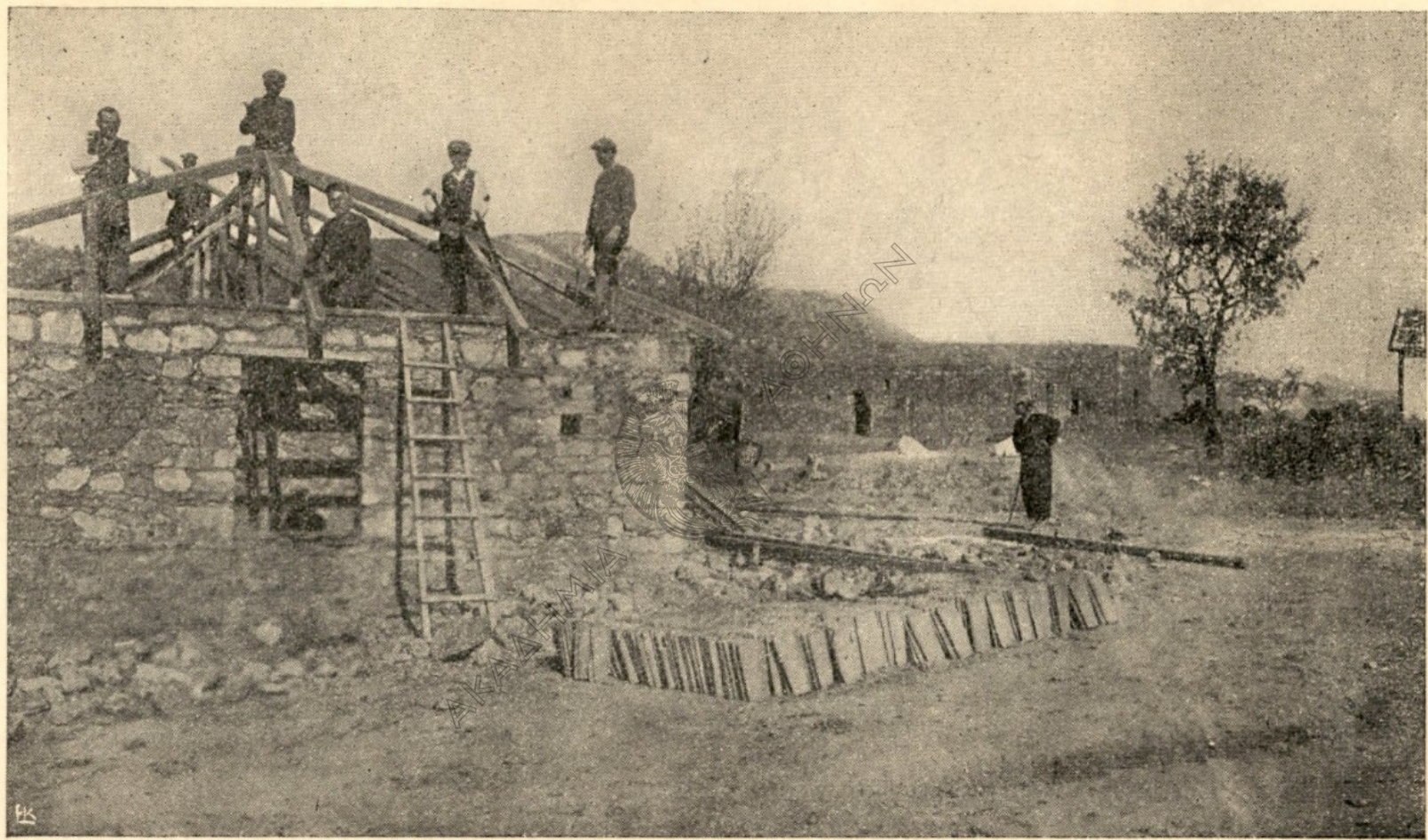
Κατασκευή προχείρων οικιών διά τούς έπανακάμπτοντας πρόσφυγας.
