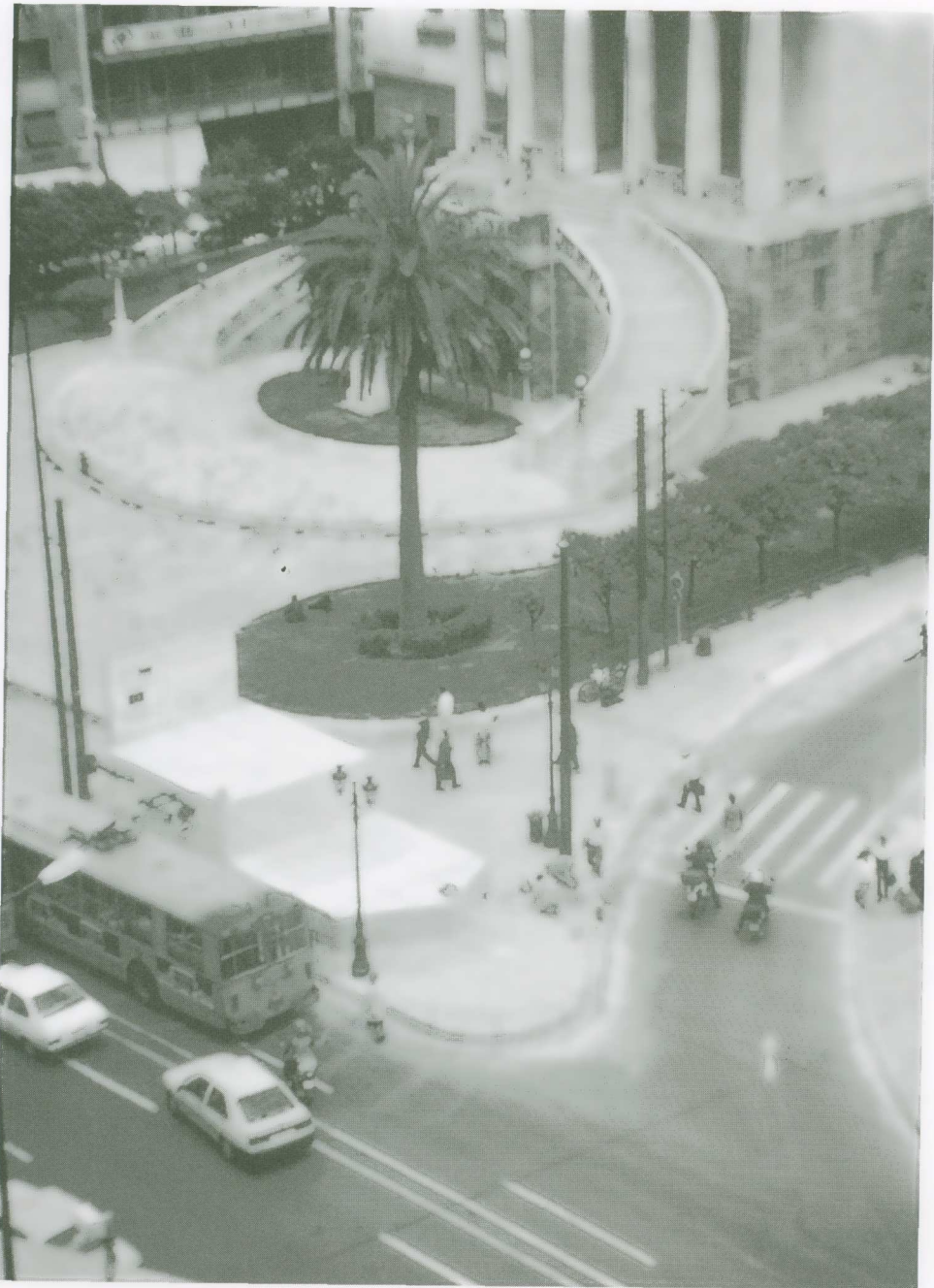
Είκ. 17. Κουβούκλιο που καλύπτει την προβλεπόμενη είσοδο-έξοδο του ΜΕΤΡΟ, πρὸ τῆς Ἐθνικῆς Βιβλιοθήκης (Φωτ. Π.Μ.Μ. 1998).
