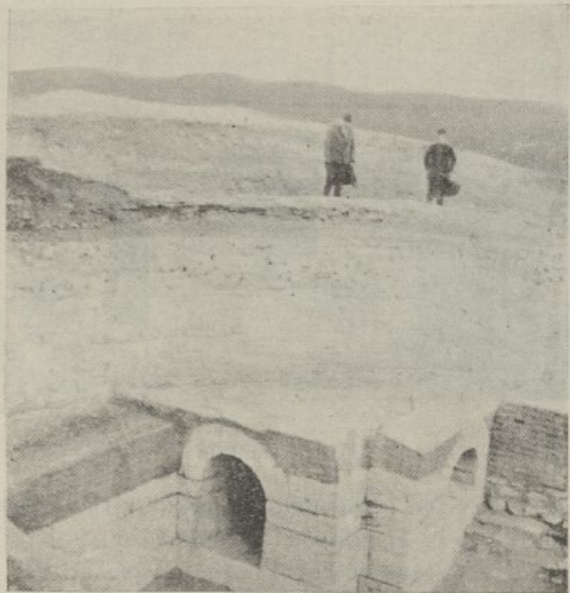
(Εἰκὼν 21). Ἐσωτερικὴ ἀποψὶς τοῦ Β.Α. τομέως και μέρος τῆς στέγης.
