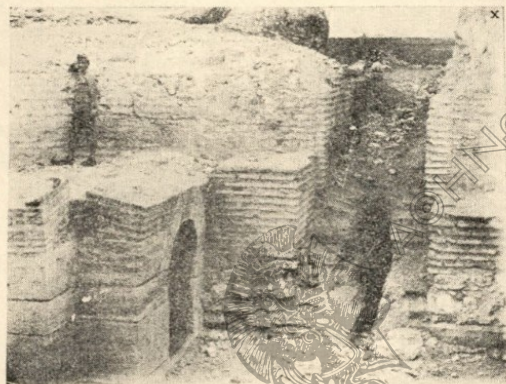
(Εἰκὼν 24). Ἀποψὶς τοῦ ἐσωτερικοῦ τῆς εἰσόδου τοῦ κοιμητηρίου καὶ ἡ ἀπαιρηθεῖσα ρωγμὴ 1920.
