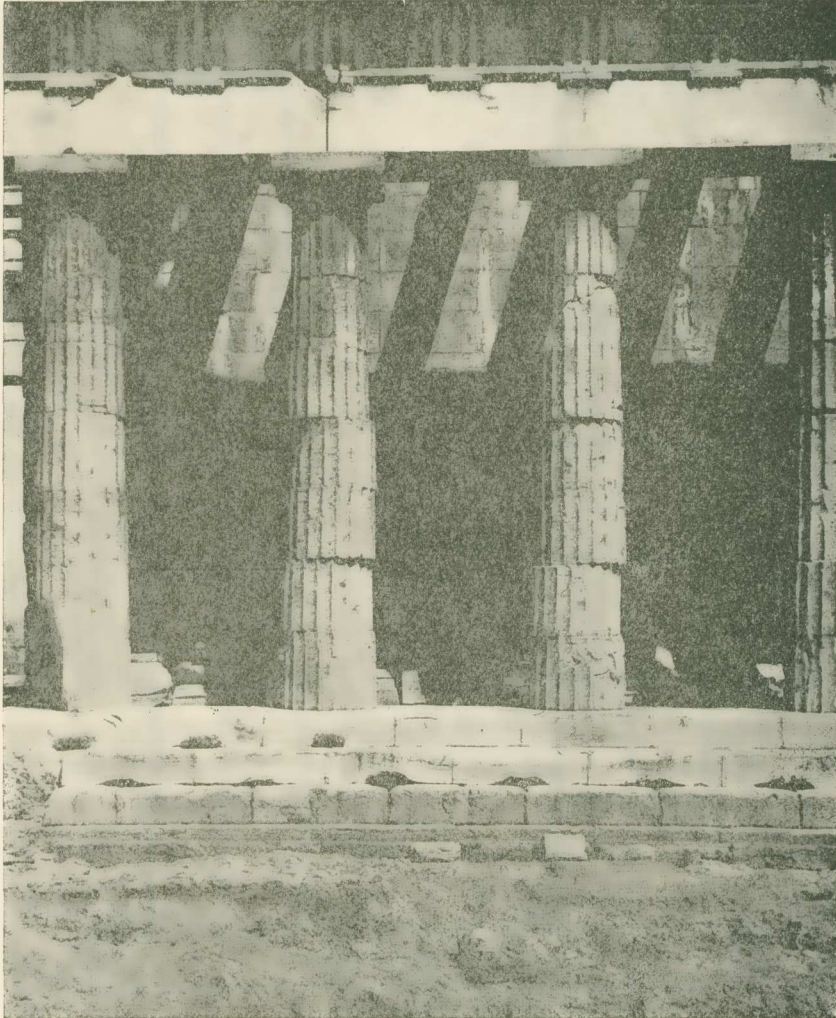
Εἰκ. 7. Μετατόπισις τῶν σπονδύλων τῶν κιόνων ἐπὶ τῆς νοτίου πλευρᾶς τοῦ Ναοῦ τοῦ Ἡφαίστου, κοιν. Θεσείου. (Ἀνέκδοτος φωτογραφία Ν. Κρητικοῦ).
